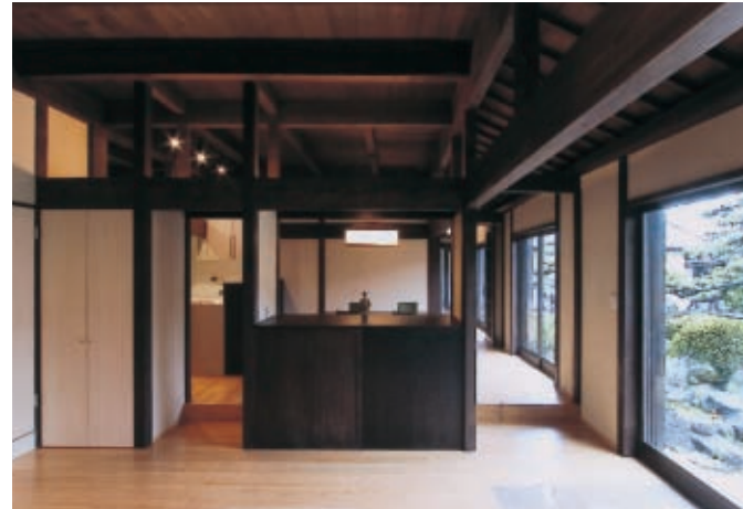
リフォーム前の玄関・ホール・洋室の壁を撤去し、リビングルームに。補強のために柱・差し鴨居等を新しく入れています。
