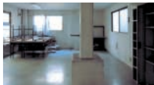
④既存1階 西側会議室
