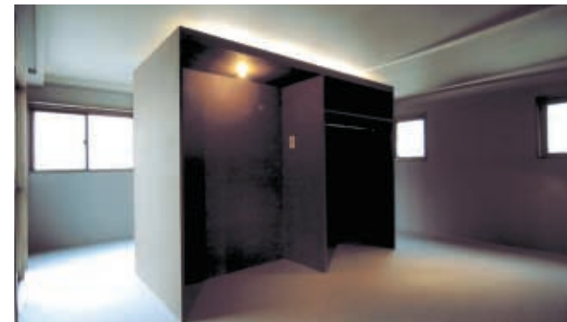
⑨改修後2階 収納によって寝室と書斎が分節される
