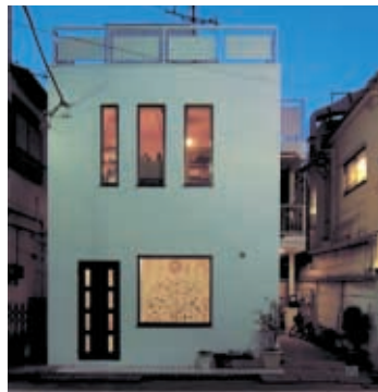
⑥改修後外観
