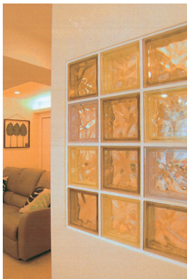
(C)キッチンとネイルスペースを間仕切るガラスブロック
