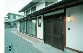
玄関は洗い出して優雅にアプローチ
