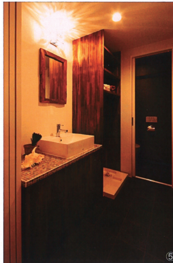
排水管を隠すため、飾り棚兼カウンターを設置した。
