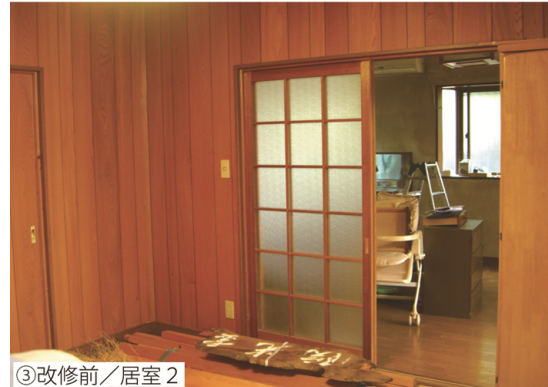
③改修前/居室2
