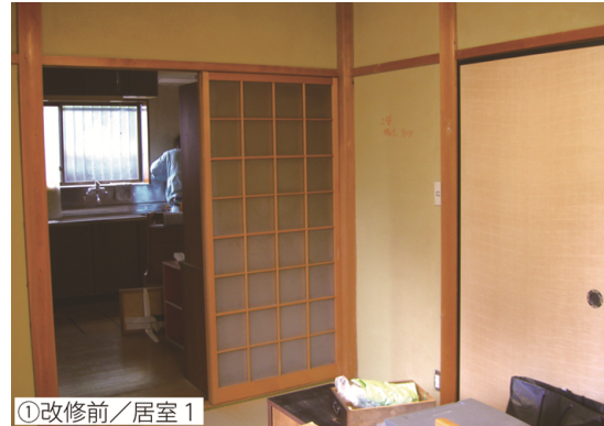
①改修前/居室1
