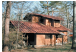
d:リフォーム前外観 1階中央面格子部分、キッチン外壁
