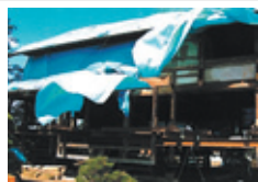
工事中：家をジャッキアップして持ち上げ基礎を新設。
