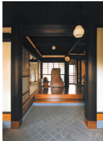
3 -a 框と床は既存の材と調和するチーク無垢材。手前両側の壁は、補強壁となっている。
