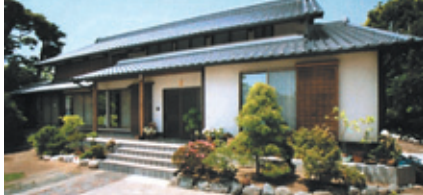
1 玄関ポーチは既存の右を再施工。右戸袋は左の既存戸袋に合わせて竹針で再現した。
