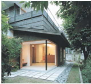
⑦庭からテラスを通してリビングを見る。床は厚さ15mmのライムストーン貼り。ライムストーンと敷石の関係も室内と外部の一体感を高めている。リビング、テラスはそれぞれ建具で仕切ることができる。
